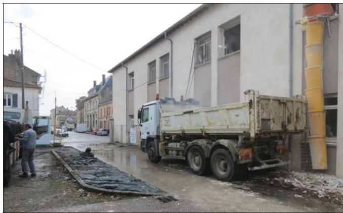
■ Le bâtiment en cours de transformation donne sur la rue Girardet.
