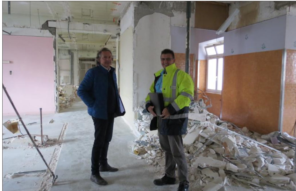
■ Dominique Aubert, architecte, et Jean-Paul Sauvageot, responsable des services techniques du CPN, dans l'espace, qui accueillera les CMP enfants et petite enfance.
