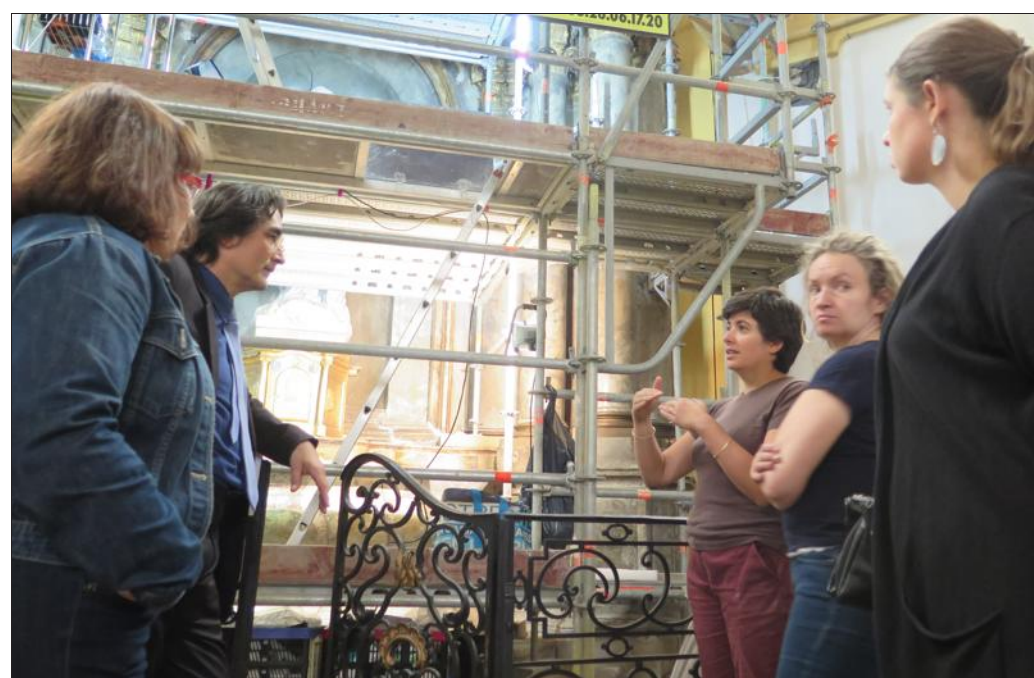
Amélie Méthivier et Jennifer Vatelot, restauratrices du patrimoine, expliquent le travail commencé cette semaine.
