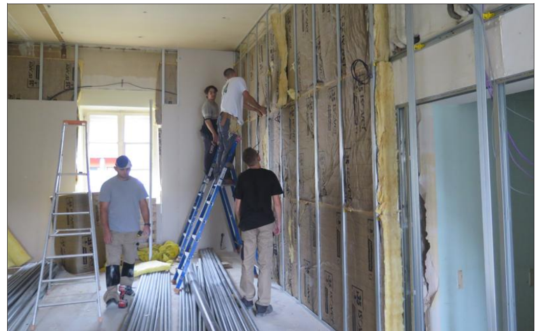
L'aile du cloître de l'hôpital en pleins travaux de rénovation.
