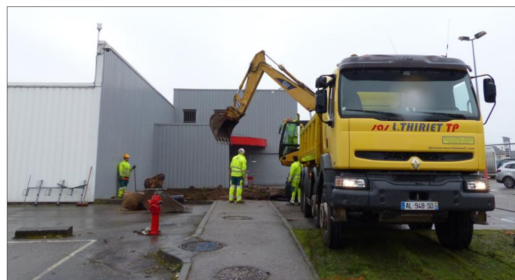
Les travaux de la nouvelle boulangerie ont débuté jeudi matin.
