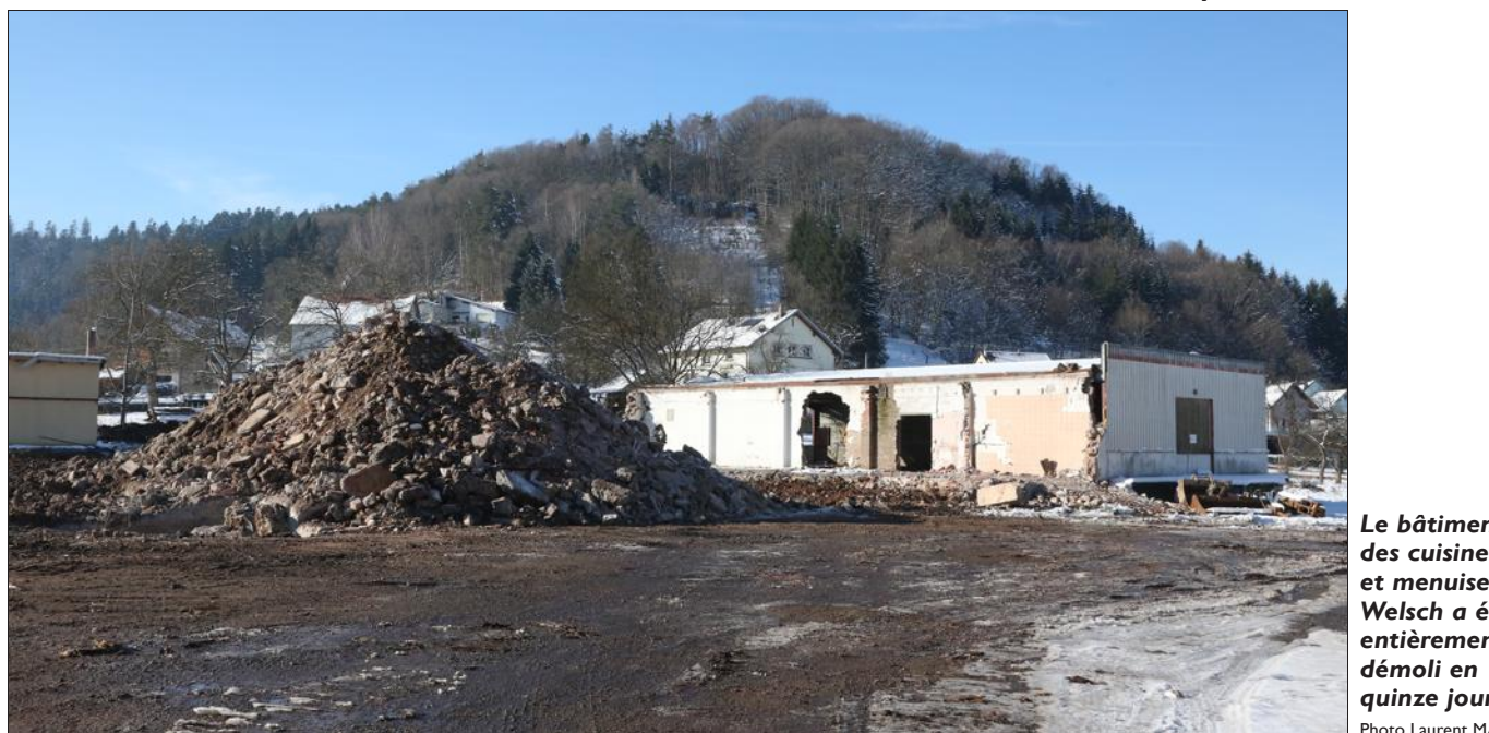
Le bâtiment des cuisines et menuserie Welsch a été entièrement démolit en quinze jours. Photo Laurent MAMI
